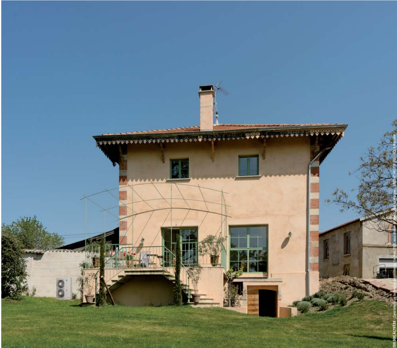
250 DDC ALTI TOP - Conception et réalisation par un maître d'œuvre d'habitat individuel - Le mas de 200 - Douzains - 31120 - 31 427 270 005 - ICS B. Maréchal
